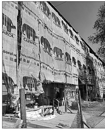
Квітень 2024: у будинку проводять також утеплення фасаду
